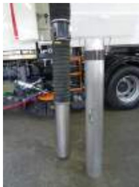
Първото удължение е прикрепено, второто е готово за прикрепване
